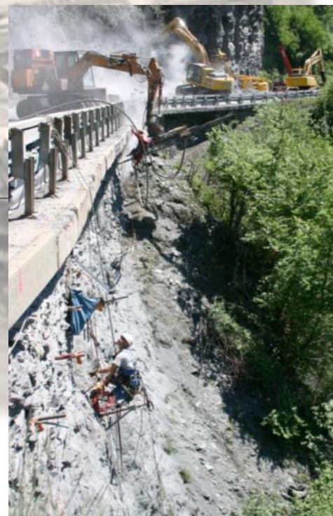
Essai de convenueance accès sur corde
