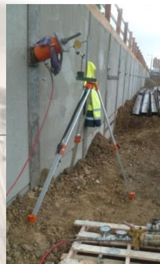
Essai de traction sur ancrage de berlinoise
